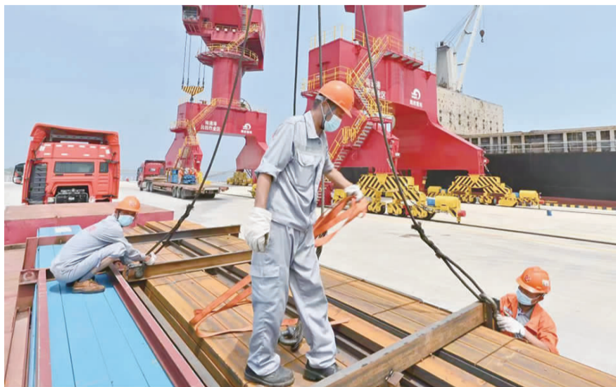
图为码头生产现场,装卸工人正在进行挂钩作业
